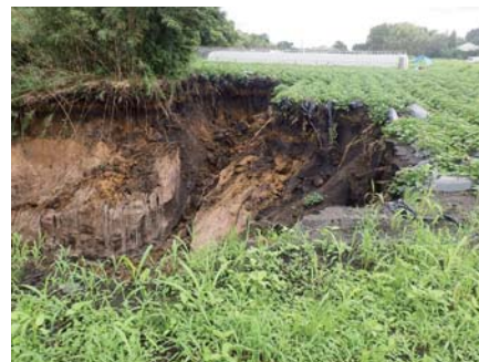
がけ崩れ等による土砂の流出
