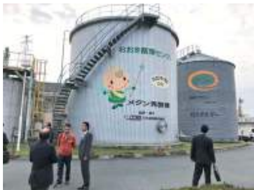
▲おおき循環センター『くるるん』。家庭から出た生ごみ・し尿・浄化槽汚泥を原料にメタン発酵を行う施設を見学しました。ガスは発電に利用され、施設の一部に使用されます。残液は、液肥として水田へ無料で配布されます。
