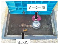
パイロット (右図の矢印) 水を使用していない時 に回る場合は漏水です。
