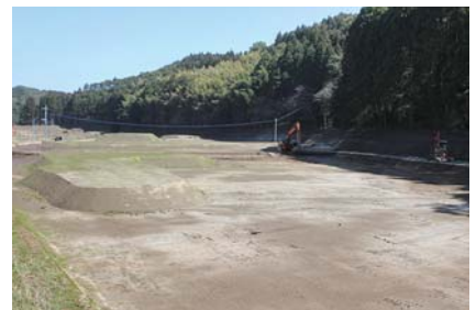
▲持留地区区画整理工事の状況
