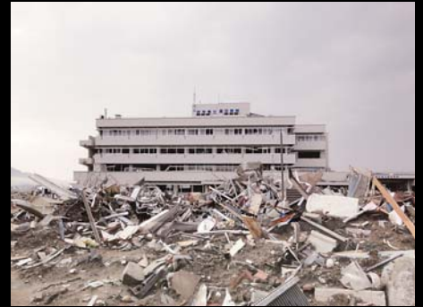
津波で壊滅状態となった陸前高田市の高田病院 6/14 撮影 建設課 岩切雄作
