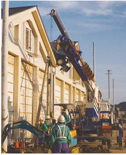
▲倉庫の屋根に打ち上げられた 車両の引きおろし作業風景
