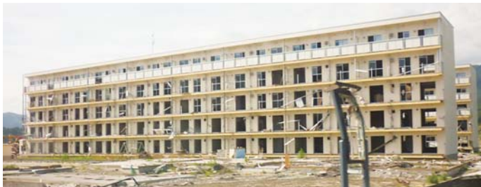
▲4階まで水に浸かったアパート
