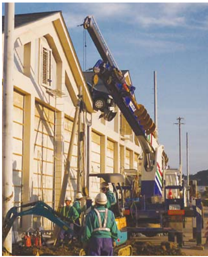
▲倉庫の屋根に打ち上げられた 車両の引きおろし作業風景
