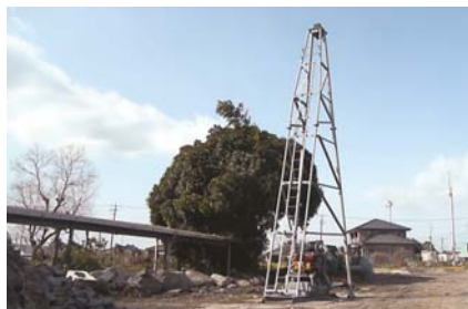
▲井戸掘削機械 会長いわく大崎は『よい水』の宝庫だそうです。
