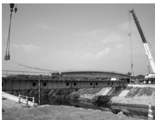
▲天子橋災害復旧工事
