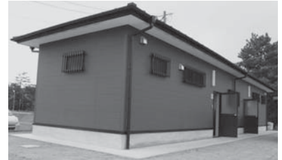
▲ビーチスポーツ専用競技場シャワー棟
