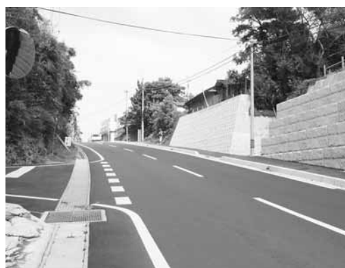
▲地方特定道路 仮宿・下原線の整備
