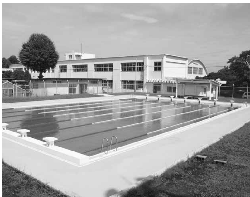
▲大崎中学校プール耐震補強工事
