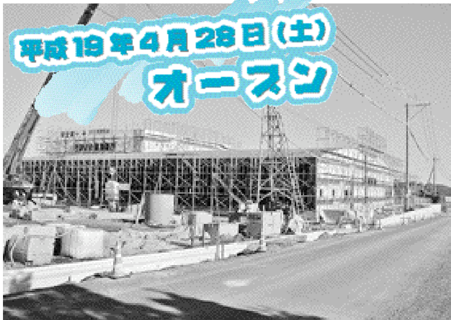
▲建設中のニューウェーブ大崎
