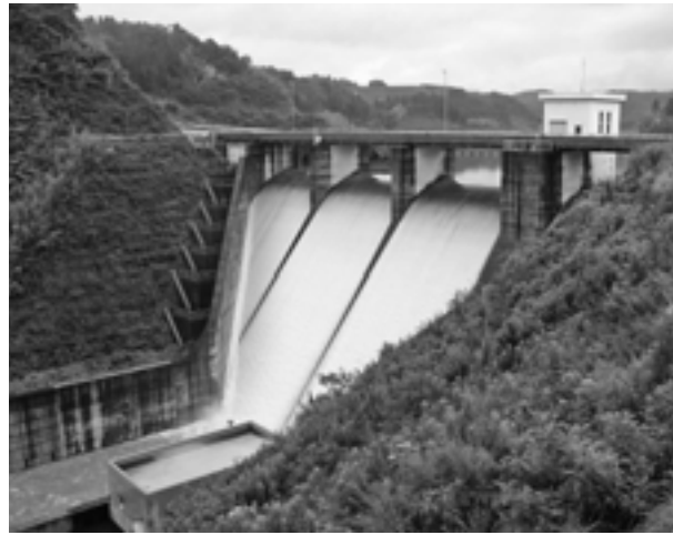
輝北ダム (平成 18 年 7 月 撮影)
