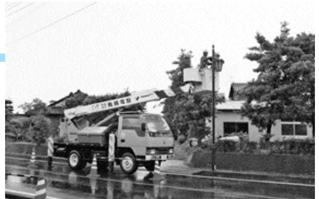
▲高所作業車で街路灯の点検作業を行う電友会のみなさん
