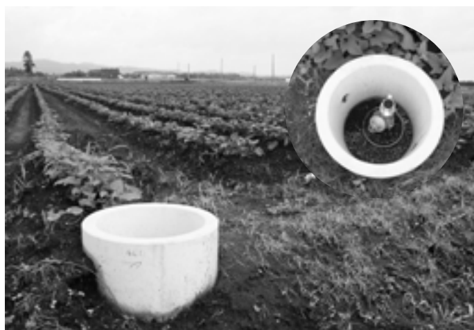
畑地かんがい事業で設置された給水栓
