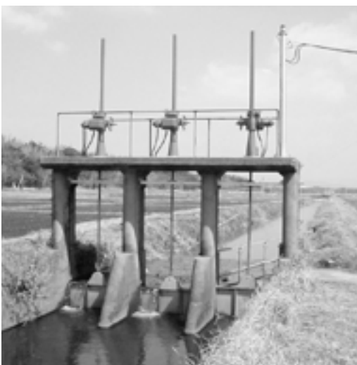
▲柳別府下井堰（三連水門）
