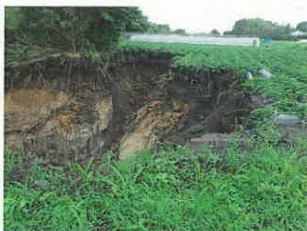
がけ崩れ等による土砂の流出
