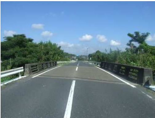
写真 6.4-1 検討される橋梁状況（橋面）
