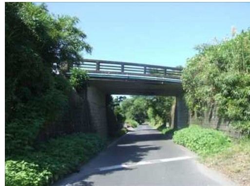
写真 6.4-2 検討される橋梁状況（側面）
