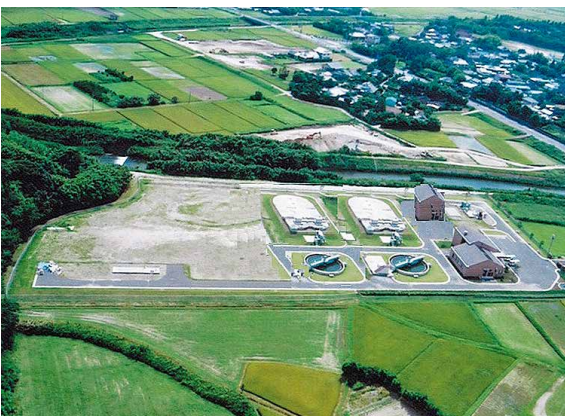
上空からの大崎クリーンセンター
