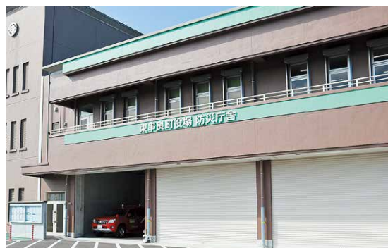
庁舎に連結して新築された防災庁舎
