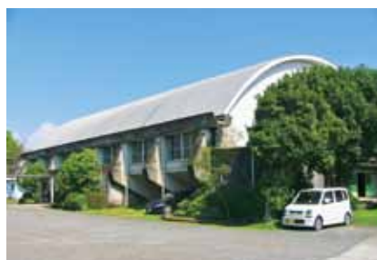
大崎中学校屋内運動場
