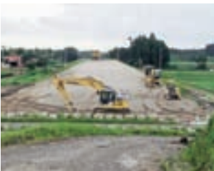
野方地区の工事状況
