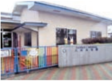
増築された事務所
