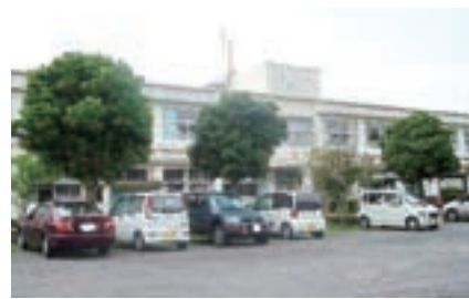
25年度耐震工事予定の大崎中学校
