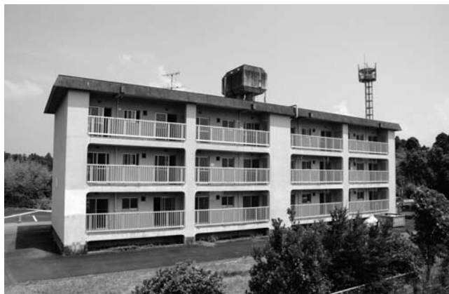
改修中の旭ヶ丘町営住宅
