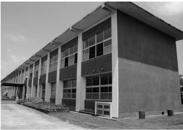
学校施設の耐震補強整備が新たに追加（野方小学校）
