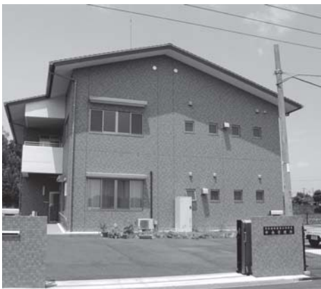
曾於南部土地改良区 中央管理所
