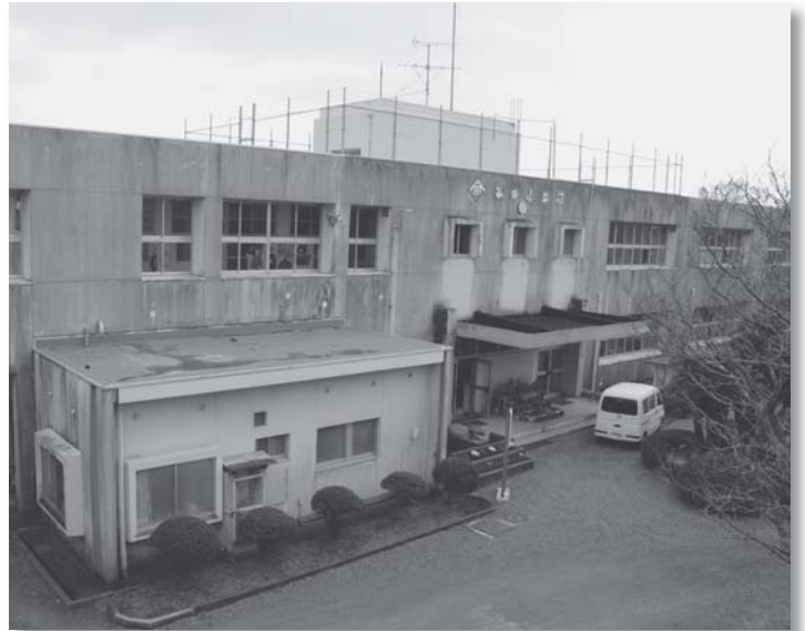
耐震診断の実施された菱田小学校校舎
