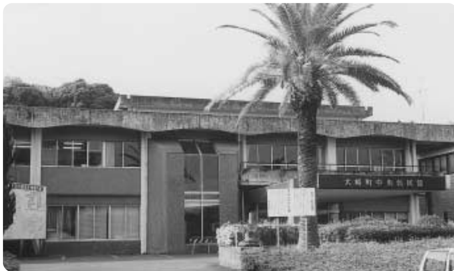
改造予定の中央公民館
